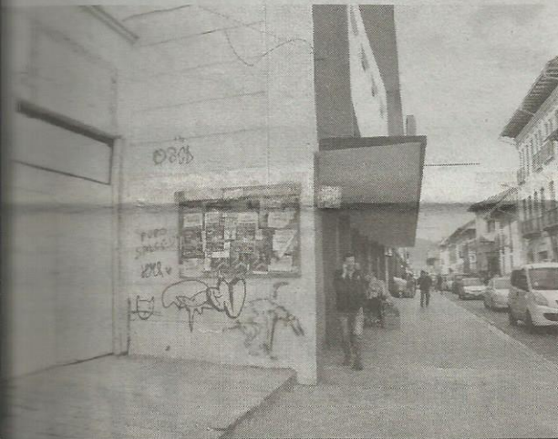
El edificio se rehabilita y se encuentra en la calle Luis Cordero, edificio de la Corte Superior de Justicia.
