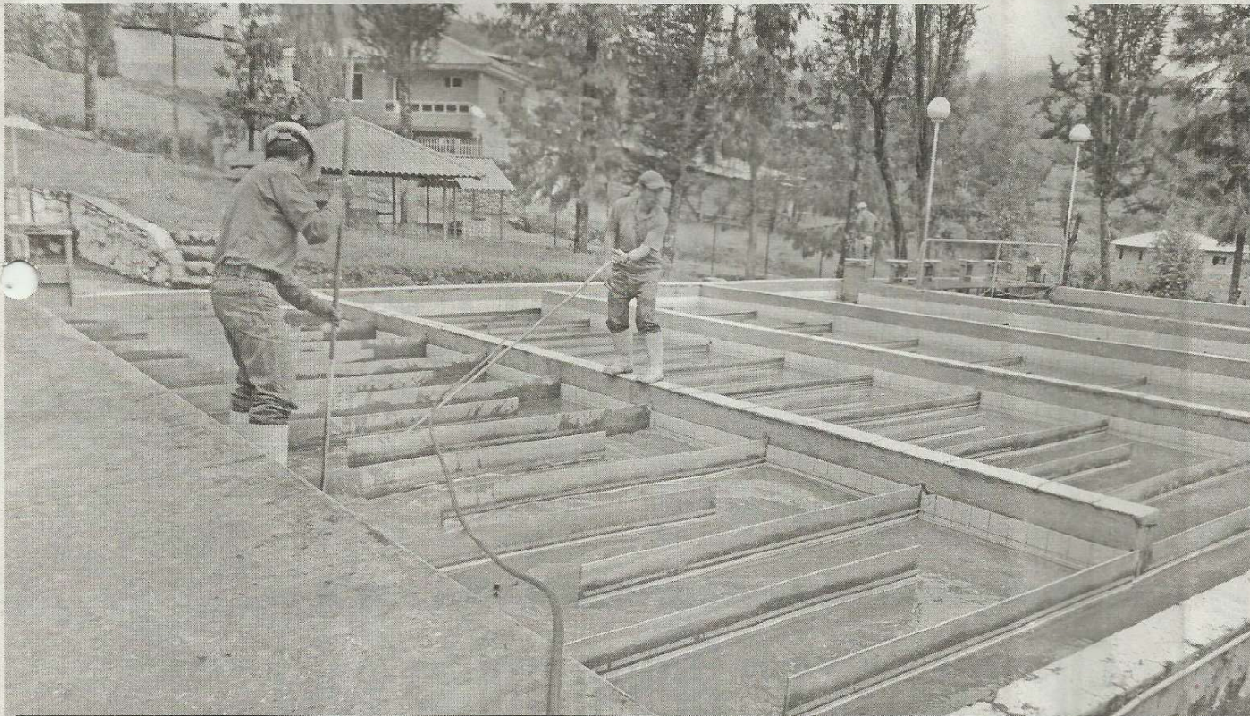
Uno de los convenios firmados por ETAPA y que está en esta discusión es la ampliación de la planta de Tixán. — Archivo
